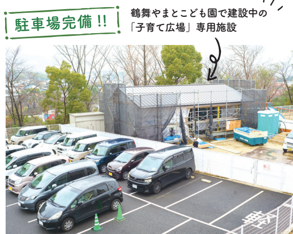
2024年2月現在の工事の様子。
